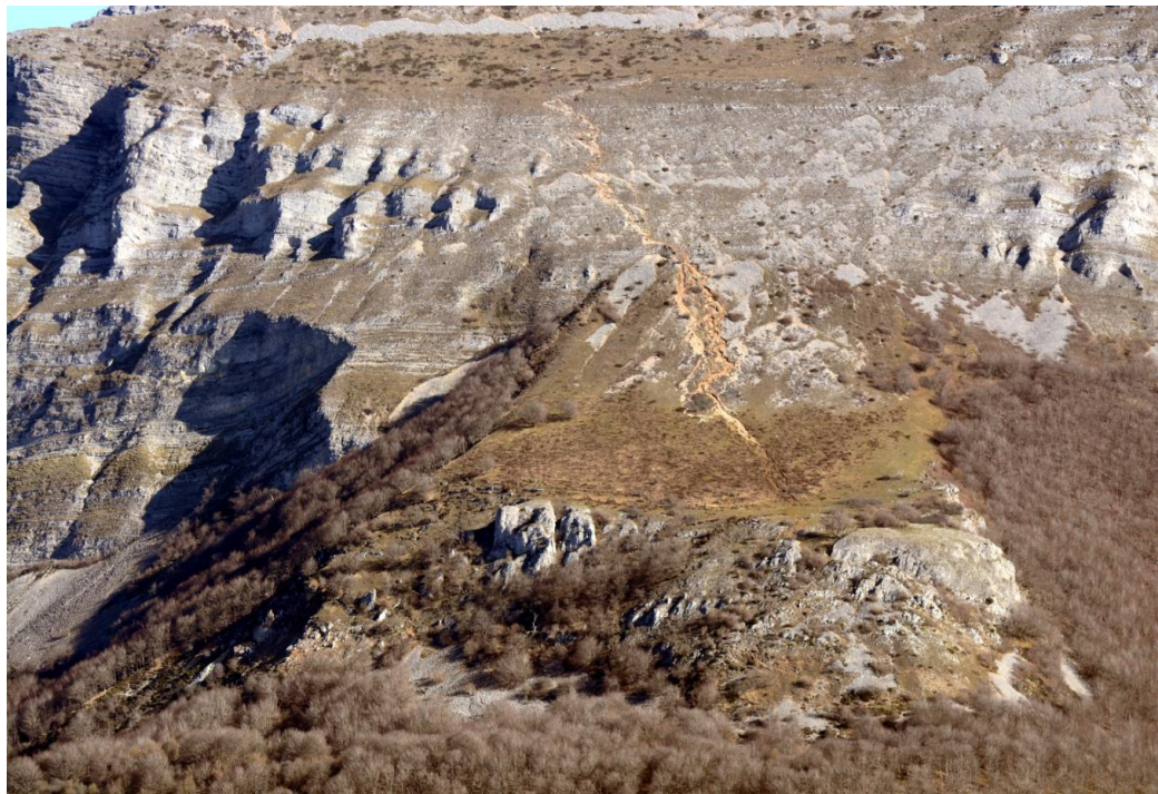
Imagen 22. Erosión en el monte Beriain provocada por el uso público.
